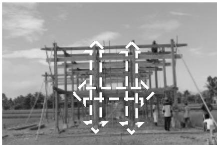
**Gambar 2.** Bentuk Struktur dan Konstruksi menyerupai Huruf “H”
